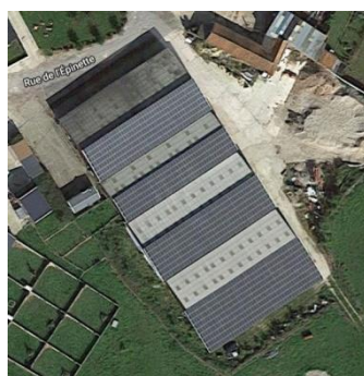
Toiture PV agricole à Bellancourt 2
